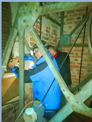
Installation eines Falkenkastens im Kirchturm in Oberdorfen
